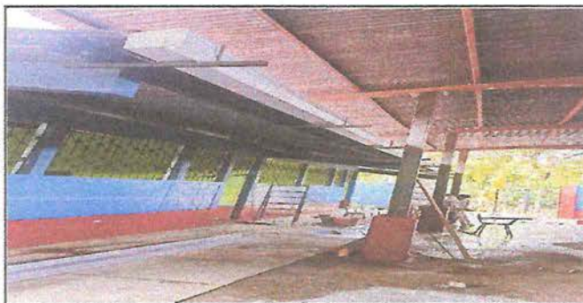
Foto 5: Sustitución de bajadas pluviales de tubo PVC3" por canales de metal.
