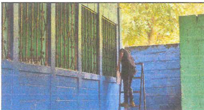
Foto 3: Mantenimiento a balcones de metal, lijado y pintura.
