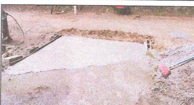
Foto 10: Reparación de rampa de acceso en la entrada al establecimiento.
