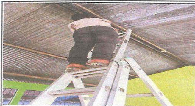
Foto 7: reparación de cableado eléctrico en salones, cocina.
