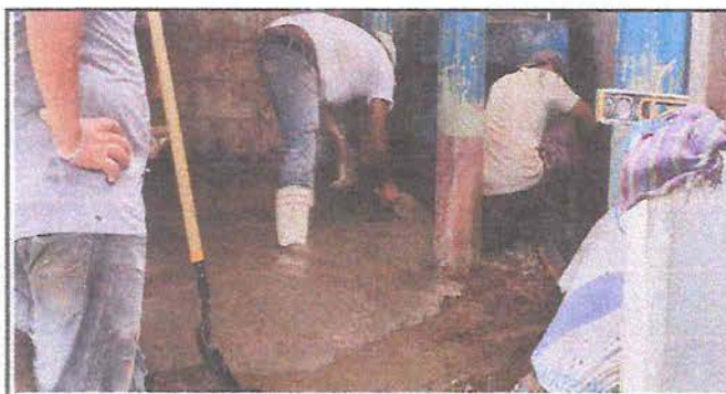
Foto 4: Sustitución de torta rustica por torta lisa de cemento
