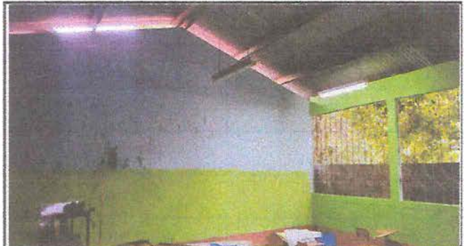
Foto 14: Aplicación de pintura en interiores de salones de clases.
