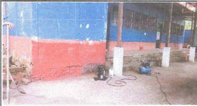
Foto13: Aplicación de pintura en paraedres exteriores de salones de clases.
