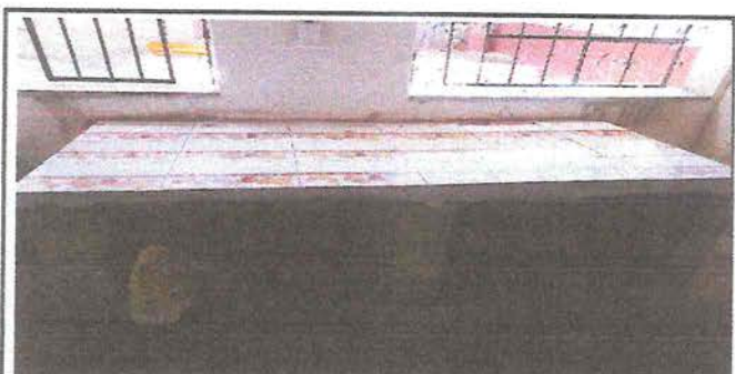
Foto 11: Implementación de azulejo en mesa de cemento y mostrador de cocina
