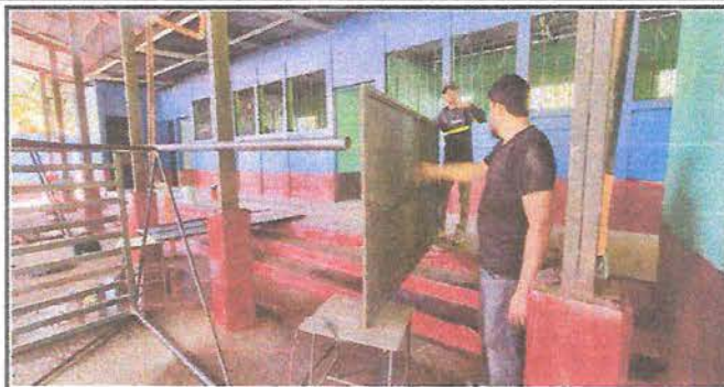
Foto 2: Sustitución de chapas en puertas de metal
