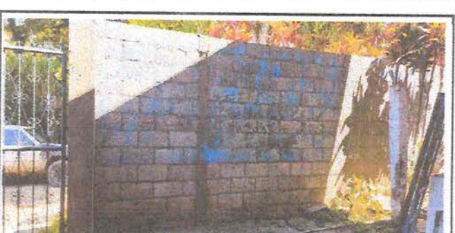
Foto 12: Aplicación de pintura en muro perimetral interior y exterior.
