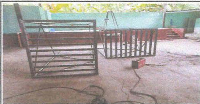
Foto 15: Contruccion de torres para tinacos con sus tinacos
