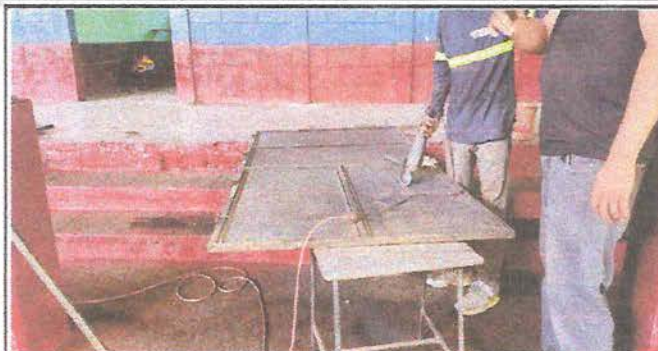
Foto1: Mantenimiento de Puerta de metal, aplicación de pintura.
