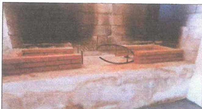
Foto 9: Implementación de hornillas de ladrillo con parrillas de hierro.
